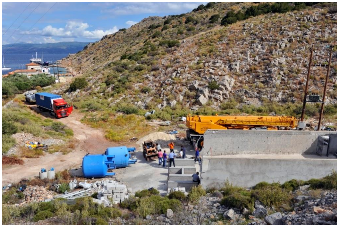
Φωτογραφία (3) εγκατάστασης μονάδας αφαλάτωσης στο Μανδράκι Ύδρας
