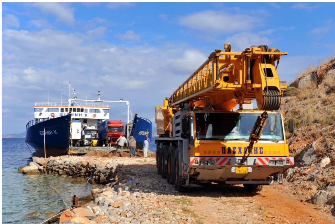
Φωτογραφία (2) εγκατάστασης μονάδας αφαλάτωσης στο Μανδράκι Ύδρας
